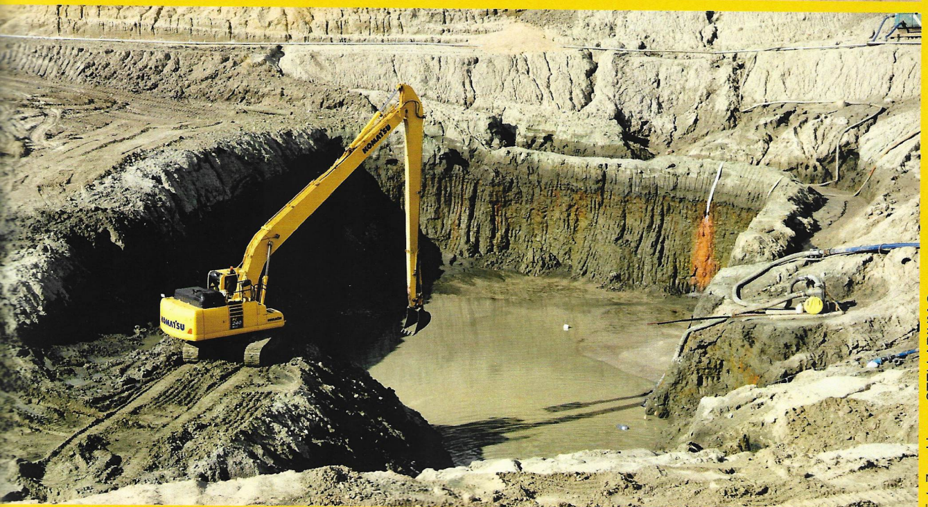
Bariera hydroizolacyjna wokół wyrobiska ZG "GLN-GLAUKO" - STELLARIUM Sp. z o.o.
